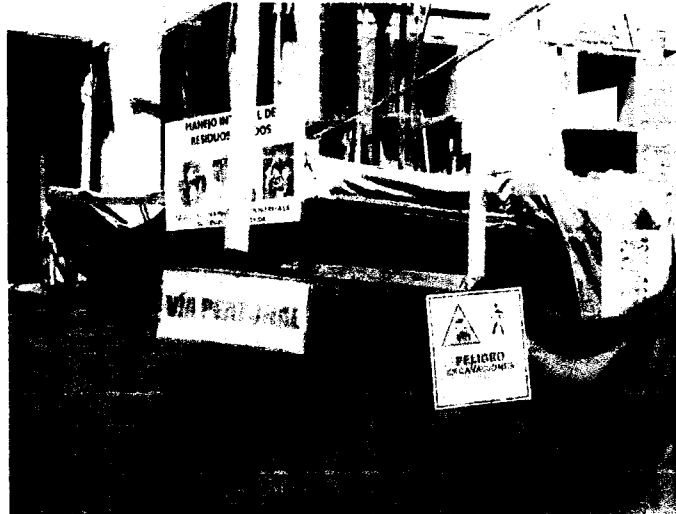
Foto 7: señalización en el exterior de la obra
