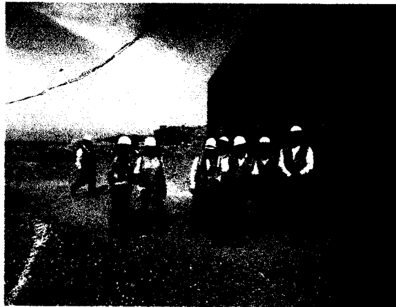
FOTO N° 10: Visita a obra de FONDEPES
