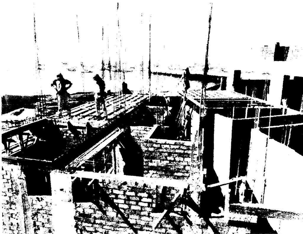
Foto N° 11: Encofrado de losa aligerada y vigas; desinfección.
