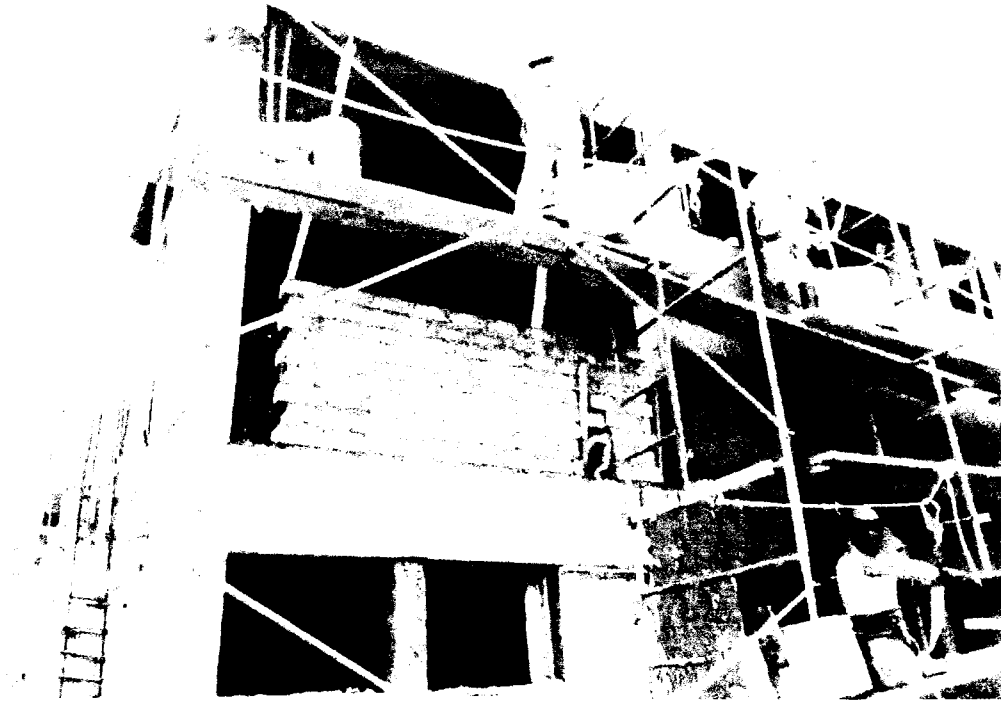
Foto N° 06: Tarrajeo de muros exteriores, vigas y columnas; servicios complementarios.
