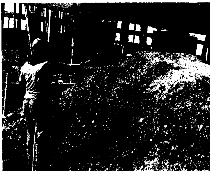
Foto 17: Mitigación de polvo mediante riego de áreas que emanan polvo
