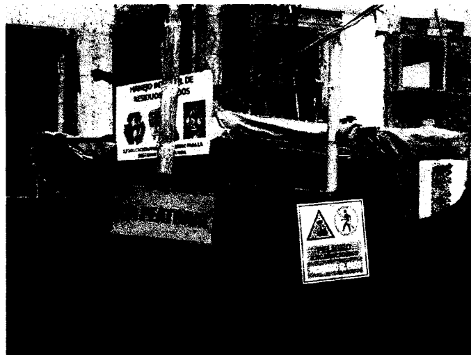
Foto N° 16 y 17: Señalización exterior de obra.
